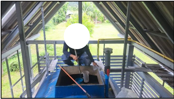
จุดเก็บตัวอย่างน้ำเสียก่อนเข้าระบบบำบัดน้ำเสีย (บ่อปรับสภาพน้ำเสีย)
